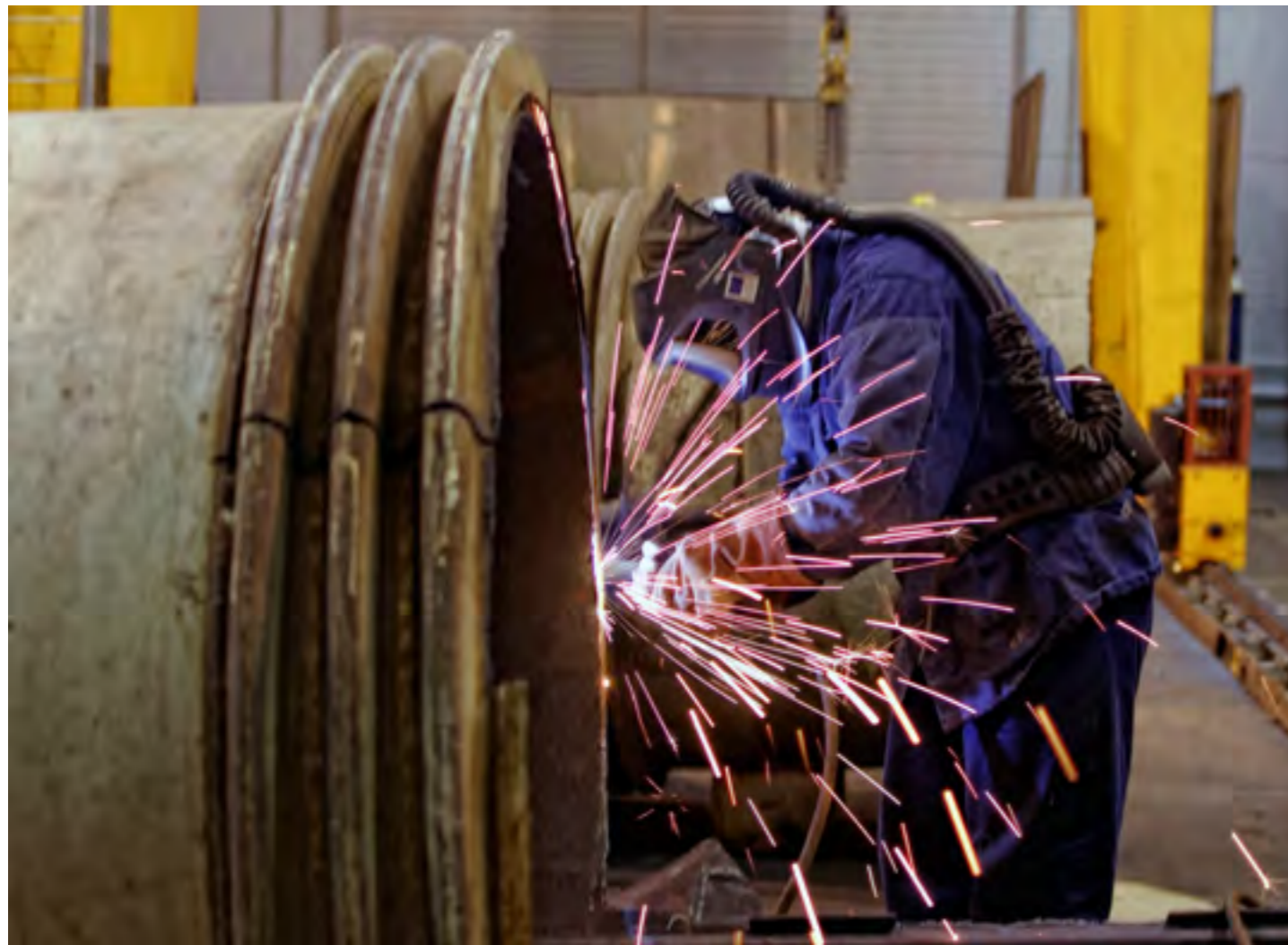
Išmontavimo darbai Ignalinos AE Dismantling works in Ignalina NPP
