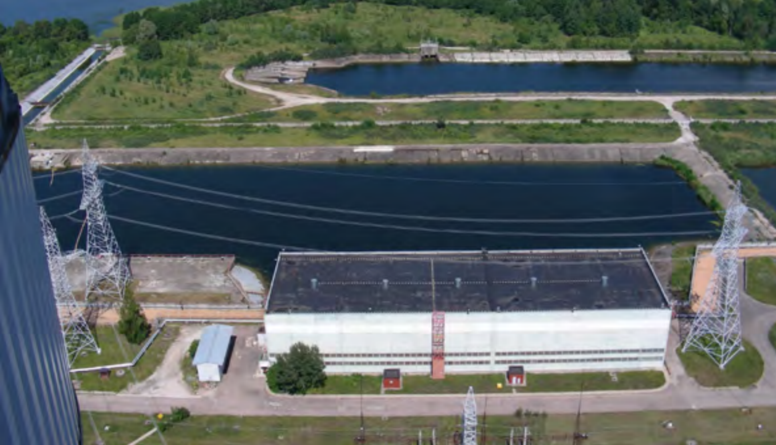
Ignalinos AE vandens siurblinė Ignalina NPP water pump station
