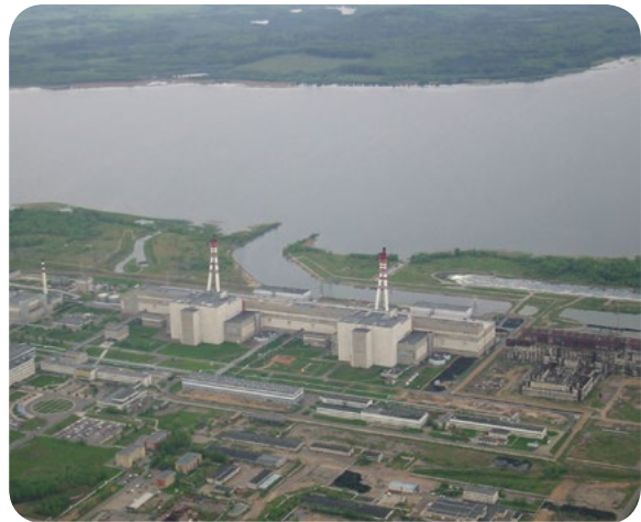
Ignalinos atominė elektrinė iš paukščio skrydžio
