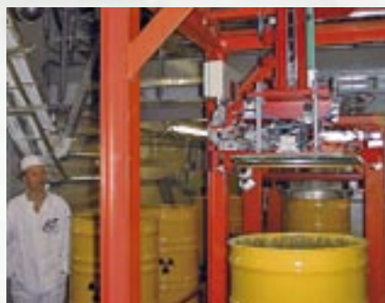
VATESI Priežiūros skyriaus vyriausiasis inspektorius Nerijus Rakštikas stebi automatizuoto konteinerių uždarymo įtaisų išbandymą.
